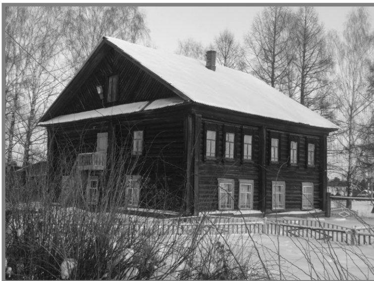
Из деревни Красильниково перевезено здание под начальную школу.
